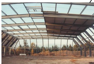
体育館を建設中
