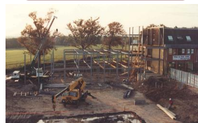
新教室建設中
